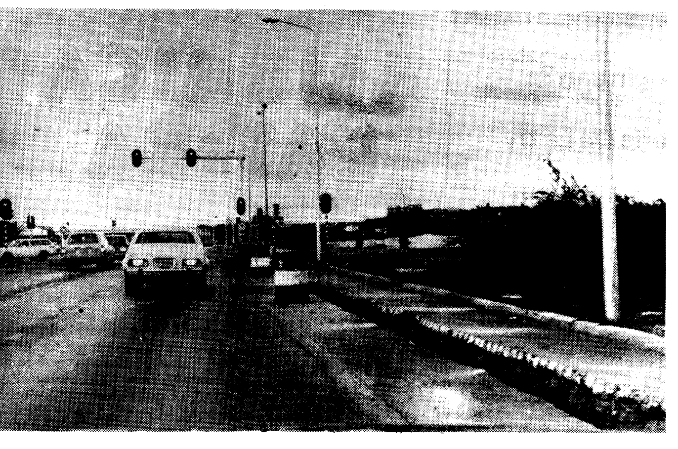
WILLEMSTAD — Langs de Rijkseenhoud boulevard — trouwens ook op meer plaatsen op het eiland — zijn geulen gegraven langs de weg voor werkzaamheden van verschillende aard. Het probleem is hierbij dat die niet goed worden afgeschermd en aangeduid, zodat automobilisten er vooral in de avonduren op worden geattendeerd. In plaats daarvan wordt niets gedaan, wat een reeel gevaar inhoudt voor ongelukken.
