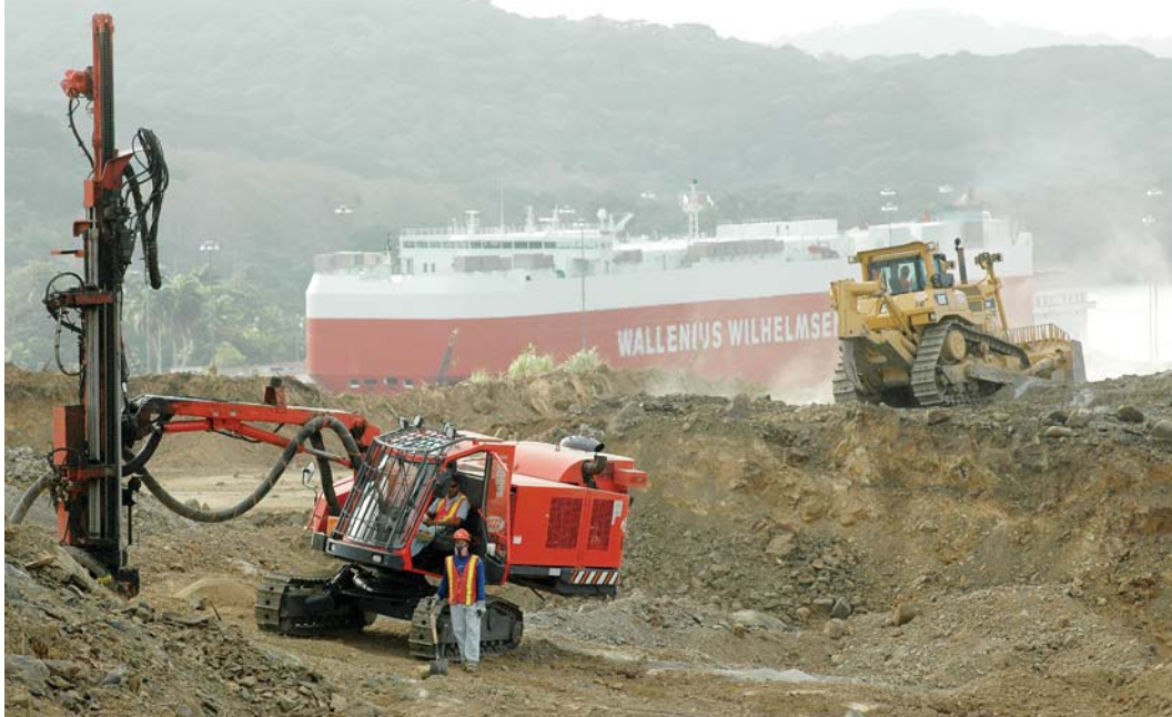
Un barco transita por el Canal, mientras que las maquinarias continúan su labor de remoción de tierra.
