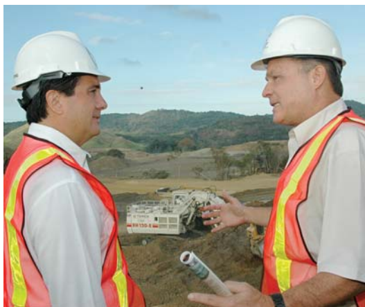
El presidente Martín Torrijos y el administrador Alberto Alemán Zubieta, durante la inspección de los trabajos.
