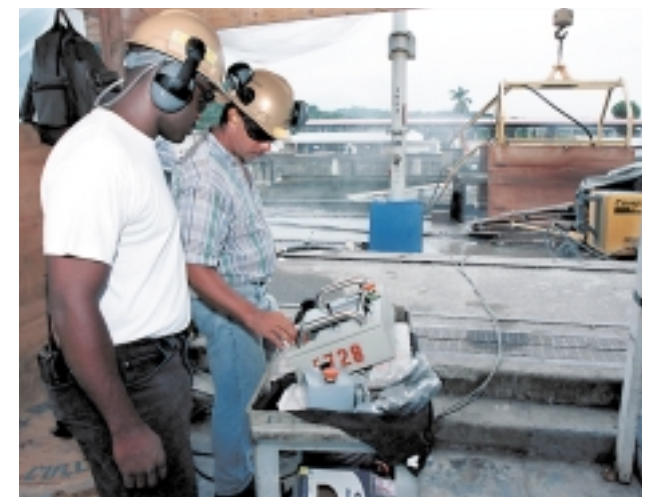
Trabajos de hidrodemolición y reemplazo de rieles en las esclusas. Este proyecto permitirá adecuar las vías de remolque de las locomotoras a la
