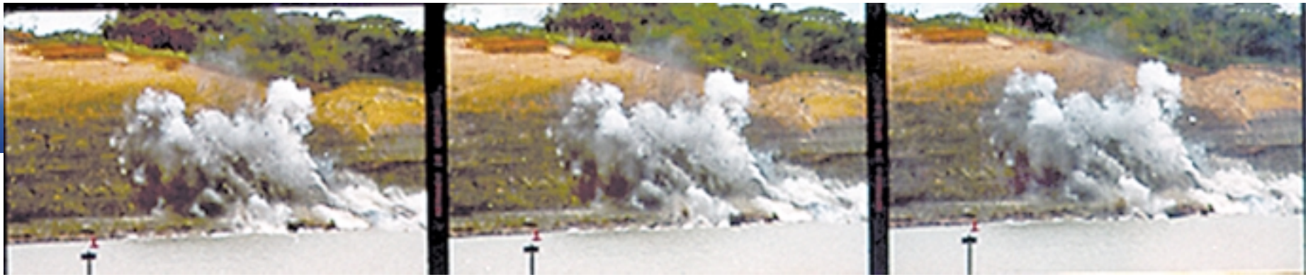
Secuencia fotográfica de la última voladura del ensanche del Corte Culebra, que se realizó el pasado 4 de julio.
