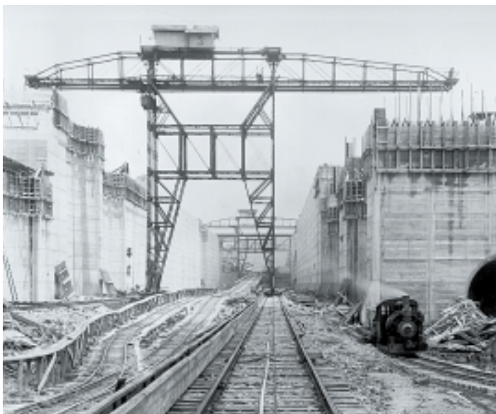
Construcción de la Esclusa de Pedro Miguel, 1911
