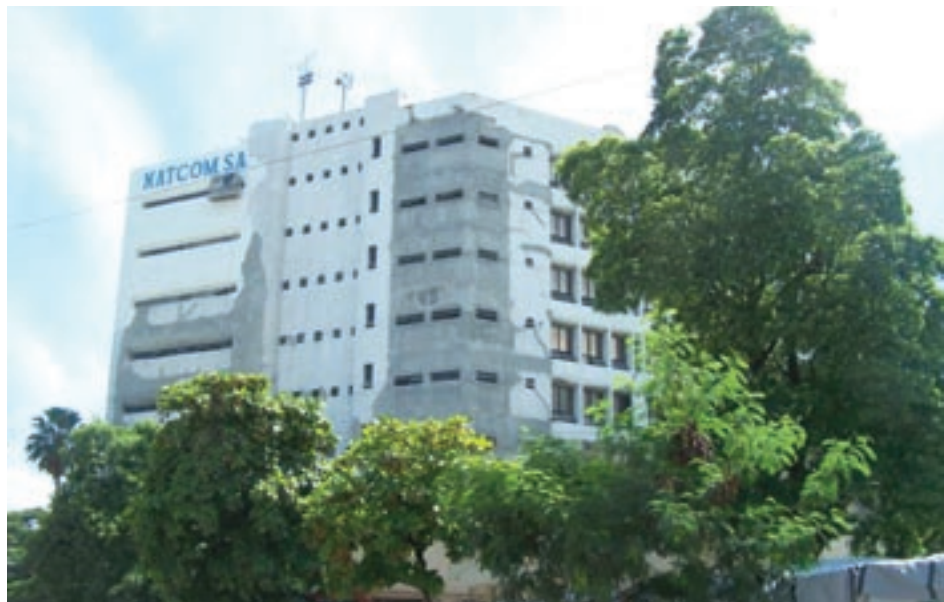
Le grand bâtiment de la Teleco devenu le siège de la nouvelle compagnie privée Natcom (photo Haïti en Marche)
