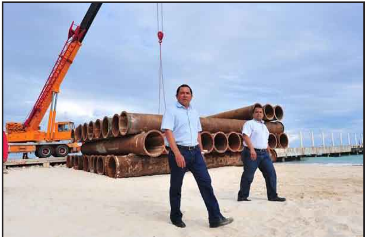
Román Quian Alcocer señaló que el proceso de armado de la maquinaria y equipo deberá concluir el 15 de enero, para posteriormente iniciar con el vertido de la arena.
