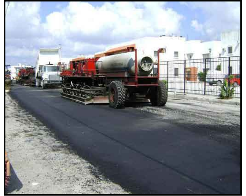
Sólo mediante recursos federales y estatales el Ayuntamiento de Benito Juárez ha podido continuar con obras como la repavimentación, pues la recaudación tributaria es por los suelos; no obstante Gregorio Sánchez sigue presumiendo "sus obras".
