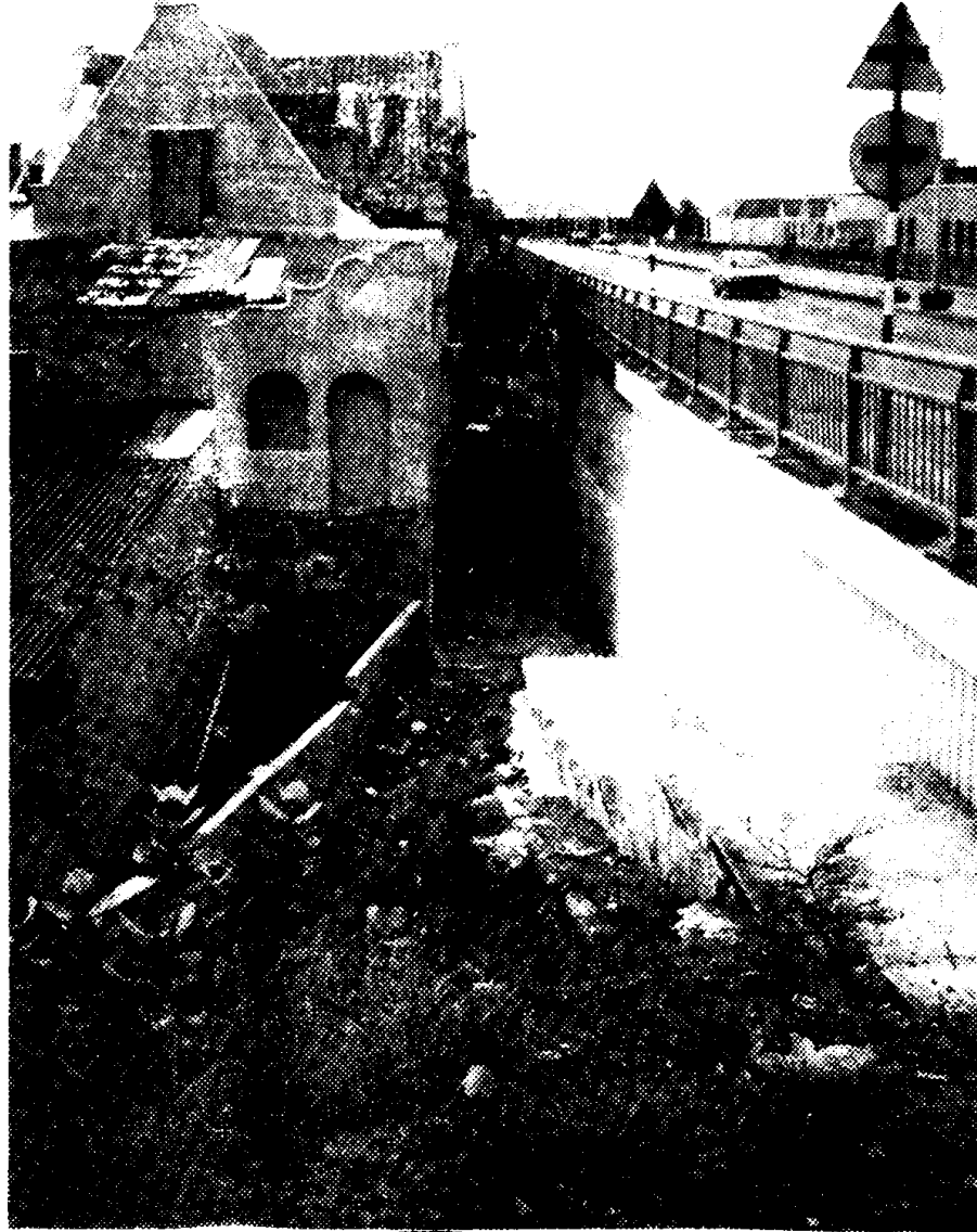
■Hier is het destijds fout gegaan met de ontwikkelingen. Het viaduct om naar Otrobanda en Westpunt te gaan doorsnijdt één van de authentieke gevels die behoren tot de trots en identiteit van Otrobanda.
