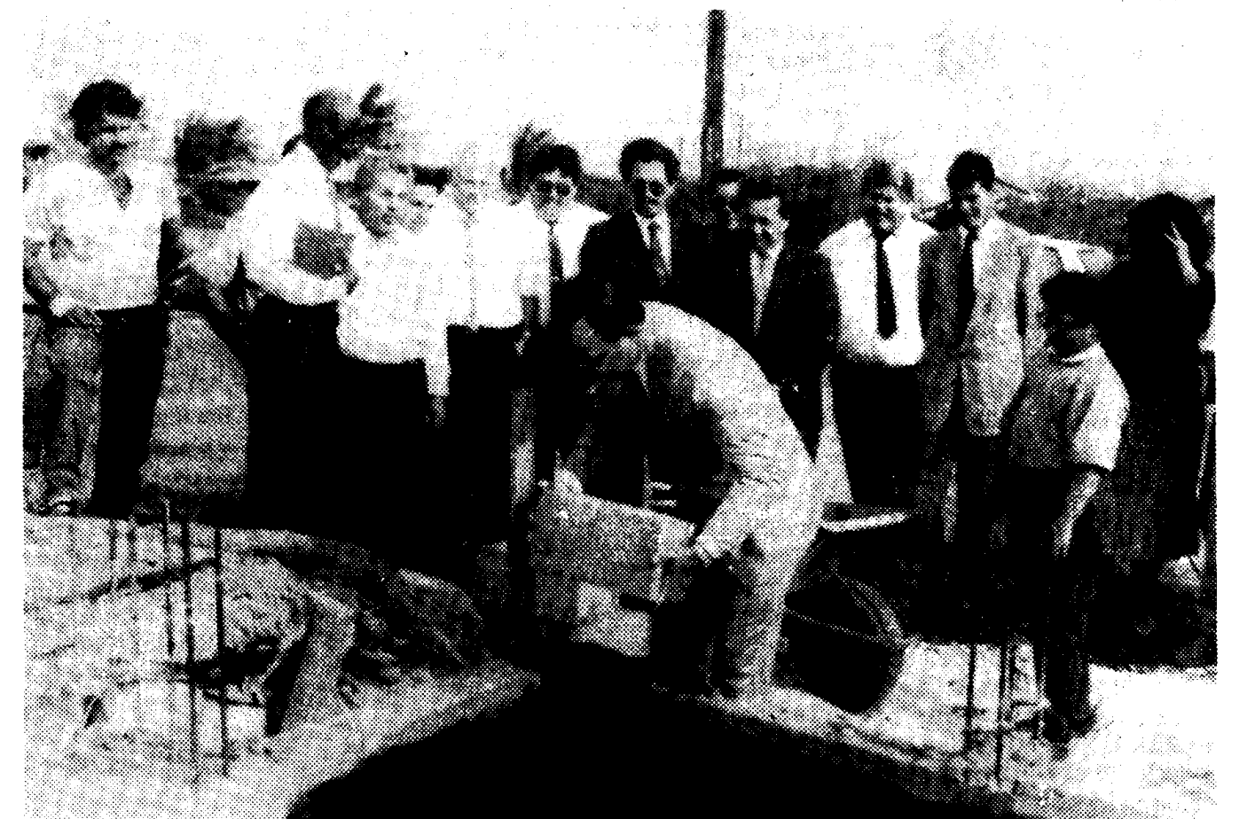
ORANJESTAD — Minister van Welzijn Fredis Bepko van der Stoep zet de eerste steen voor het nieuwe gebouw van het Centro di Barrio Lago Heights (CBLH) op zijn plaats. Het nieuwe gebouw komt op dezelfde plaats waar twee jaar geleden het eerste gebouw van het CBLH door brand verwoest werd.
