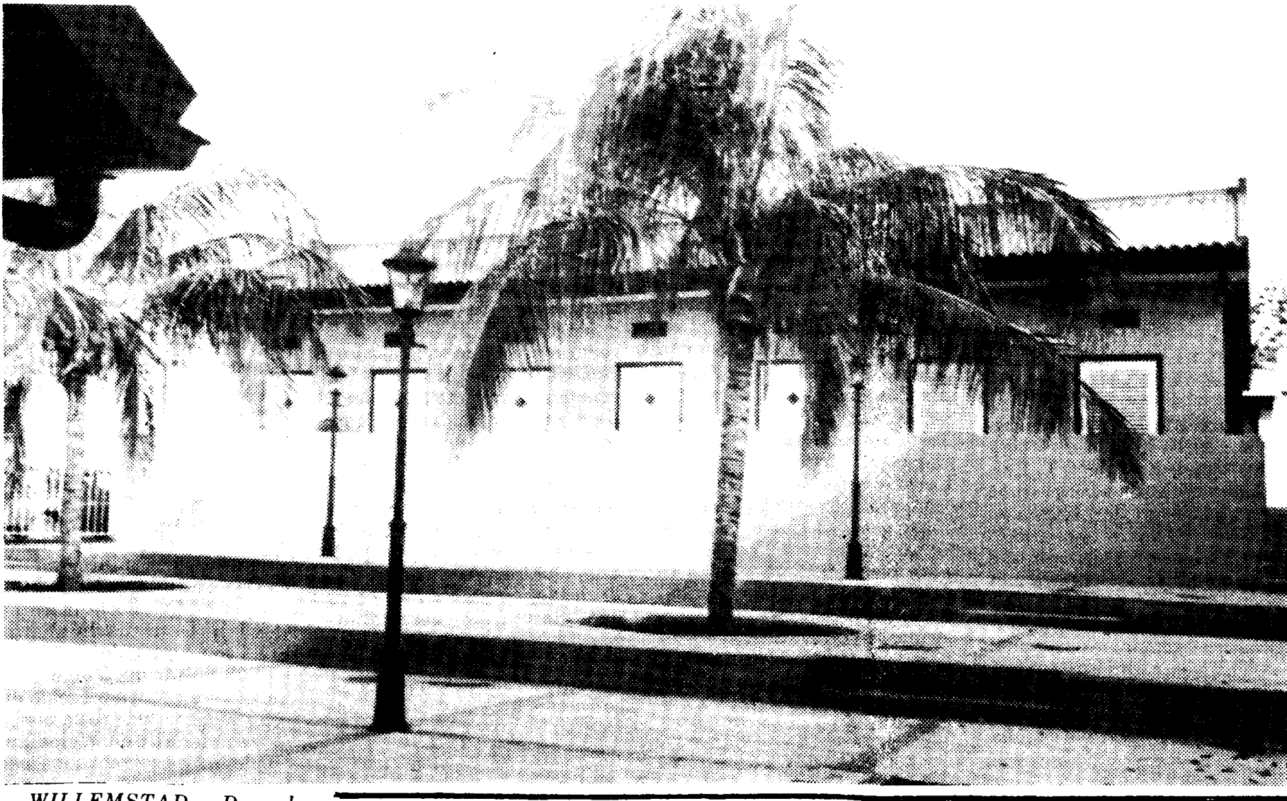
WILLEMSTAD — De oude markthallen in Otrabanda hebben sinds de voltooiing van de renovatie-werkzaamheden een volstrekt ander aanzien gekregen. De al geruime tijd niet als zodanig functionerende markthallen, werden voor aanvang van de renovatie in hoofdzaak gebruikt als illegale vuilstort- plaatsen en vormden daardoor een wezenlijk gevaar voor de volksgezondheid. Opknappen van de markthallen maakt deel uit van het Actieplan ter herstel van de binnenstad.
