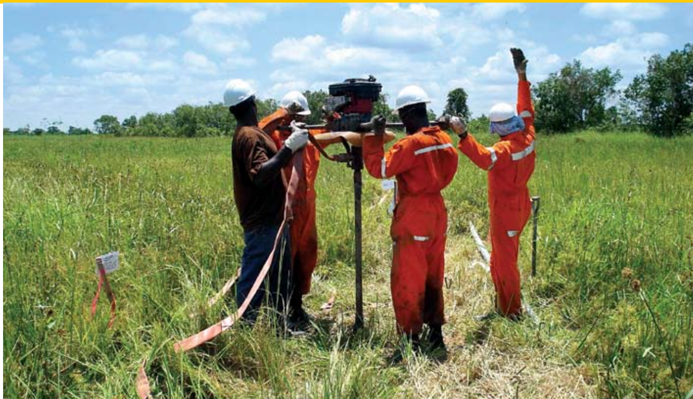
Arbeiders boren de gaten waarin de lading explosieven geplaatst wordt. Crews drill holes for the explosive charges.
