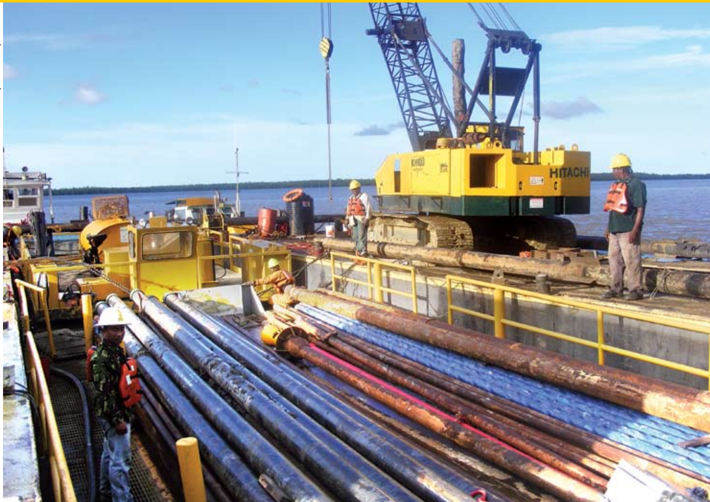
Transport van machines en materiaal over de Surinamerivier naar de rechteroever van de Commewijnerivier, waar de exploratieboringen plaatsvinden. Transporting machines and equipment across the Suriname River to the right hand bank of the Commewijne River, where the exploration drillings are taking place.
