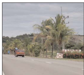
La Carretera Holguín-Guardalavaca fue reconstruida totalmente.
