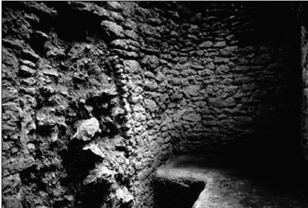
BANCA Y PARED BIEN PRESERVADA EN EL INTERIOR DE UN CUARTO DE ACROPOLIS H'MENA, ATESTIGUANDO LA CALIDAD DE LA ARQUITECTURA EN EL PILAR
