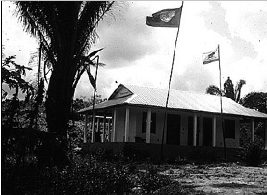
LA CASA DE GUARDIAN DEL PILAR, CONSTRUIDA CON FONDOS COMBINADOS DE USAID Y EL PROGRAMA EL PILAR
