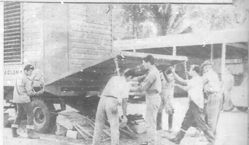
Todo el mundo trabaja en el montaje de la casa-hospital-vehículo...
