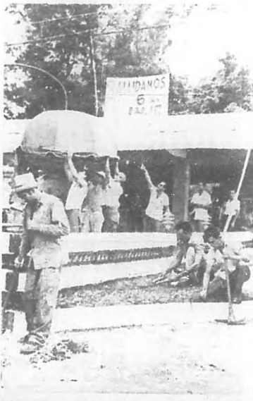
Numerosas obras se terminaban, en salud a la fecha del 21 de Octubre.
