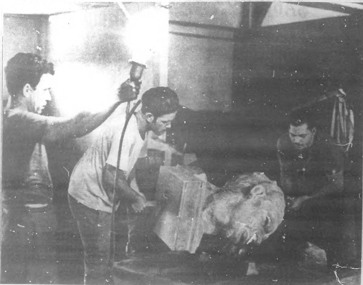
La armería ha sido convertida en fábrica de artículos para la paz. Aquí, los moldes de arena de donde se van sacando los calderos de aluminio fundido.
