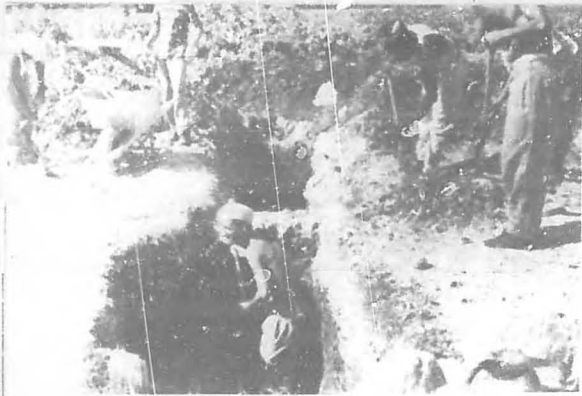
Se cavan zaujas profundas a través del terreno arcilloso buscando el firme para fijar los cimientos de las futuras edificaciones.
