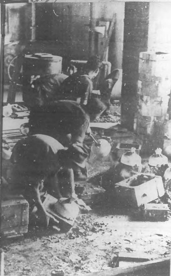
La armería ha sido convertida en fábrica de artículos para la paz. Aquí, los moldes de arena de donde se van sacando los calderos de aluminio fundido.
