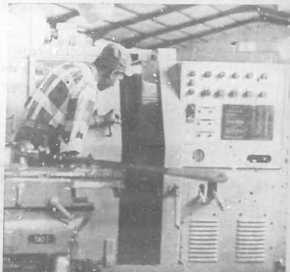
Entre las maquinarias y equipos de que se disponen en las naves industriales de la antigua armería, está este torno revólver electrónico, que nunca se llegó a usar antes, y ahora cobrará actividad.
