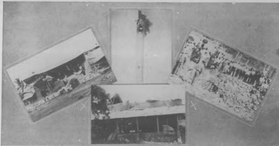
SINIESTRO EN PANAMA. Estado en que quedó una palma distante 60 metros del polvorín. Solar del polvorín. Estado de una fábrica de mantequilla y jabón a 50 metros de el polvorín. Otro aspecto de las ruinas de la fábrica.
