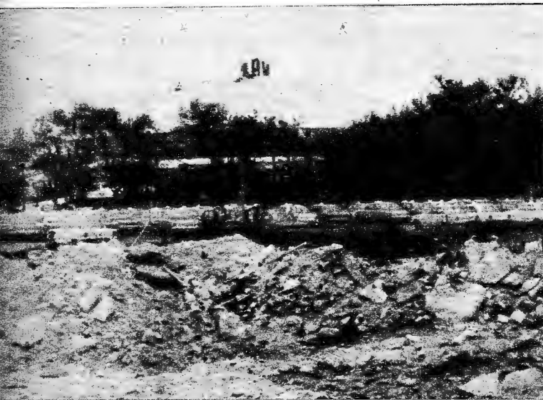
Los escombros depositados en el terreno de pelota han obstaculizado el funcionamiento del dren rectangular del Cerro.
