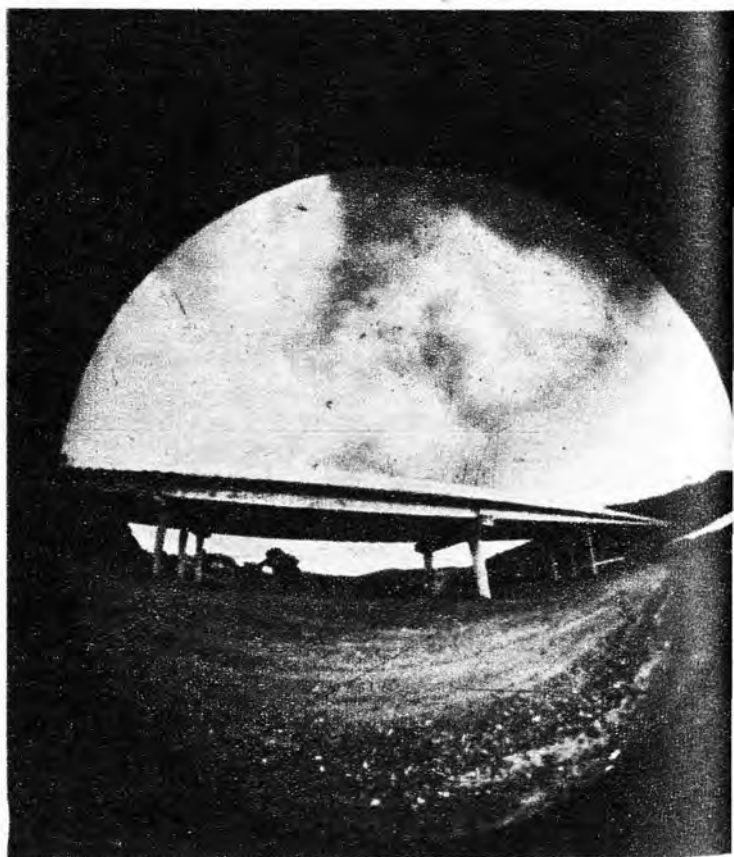
Puente de 300 m sobre el río Sagua de Tánamo. Es el más largo de la provincia.
